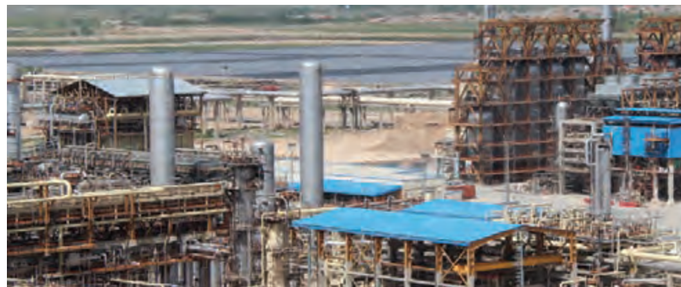
شکل ۴- نمایی از یک برج تقطیر برای جداسازی اجزای هوا در پتروشیمی ماهشهر
