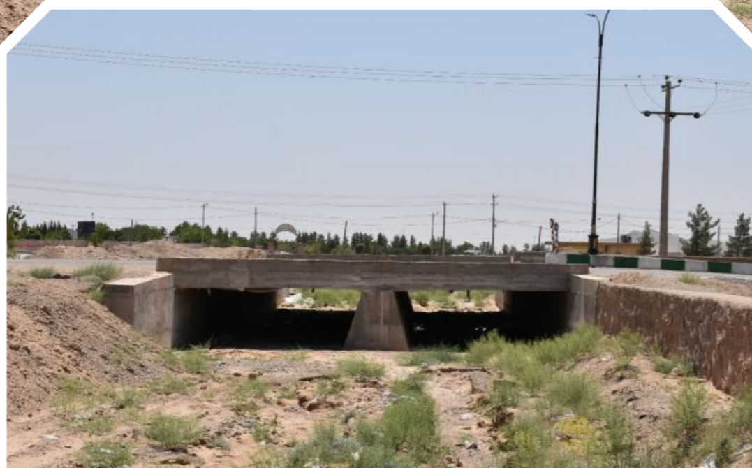
اجرای پل خیابان رازی شمالی
