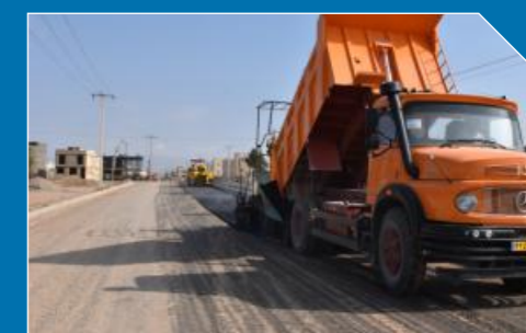
زیر سازی و آسفالت بلوار رازی شمالی
